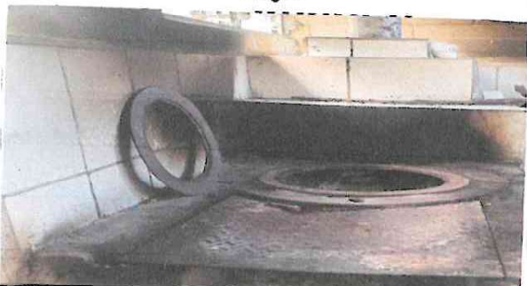
Foto 1: Sustitución de estufa rural por plancha de metal de dos hornillas
