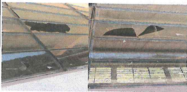
Foto 3: Reparación de ventanas
