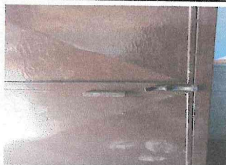
Foto 4: Sustitución de chapas
