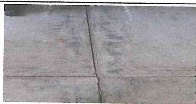
Foto 5: Sustitución de piso por piso cerámico
